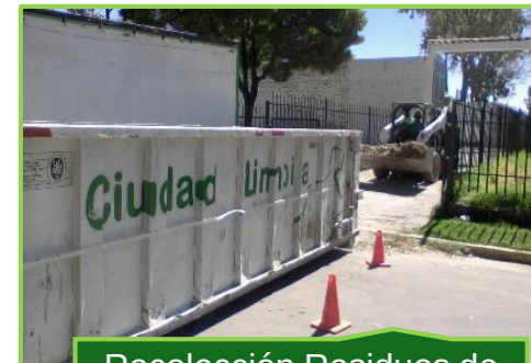
Recolección Residuos de Construcción y Demolición
